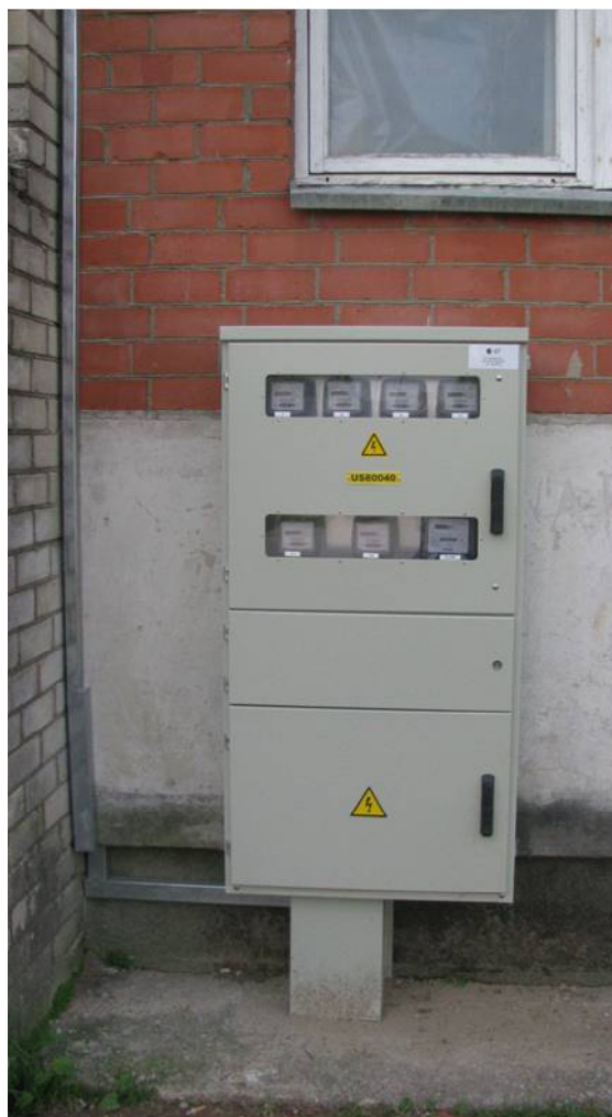
6.9. attēls. Daudzdzīvokļu uzskaites sadalne, uzstādīta ārpusē pie mājas sienas
