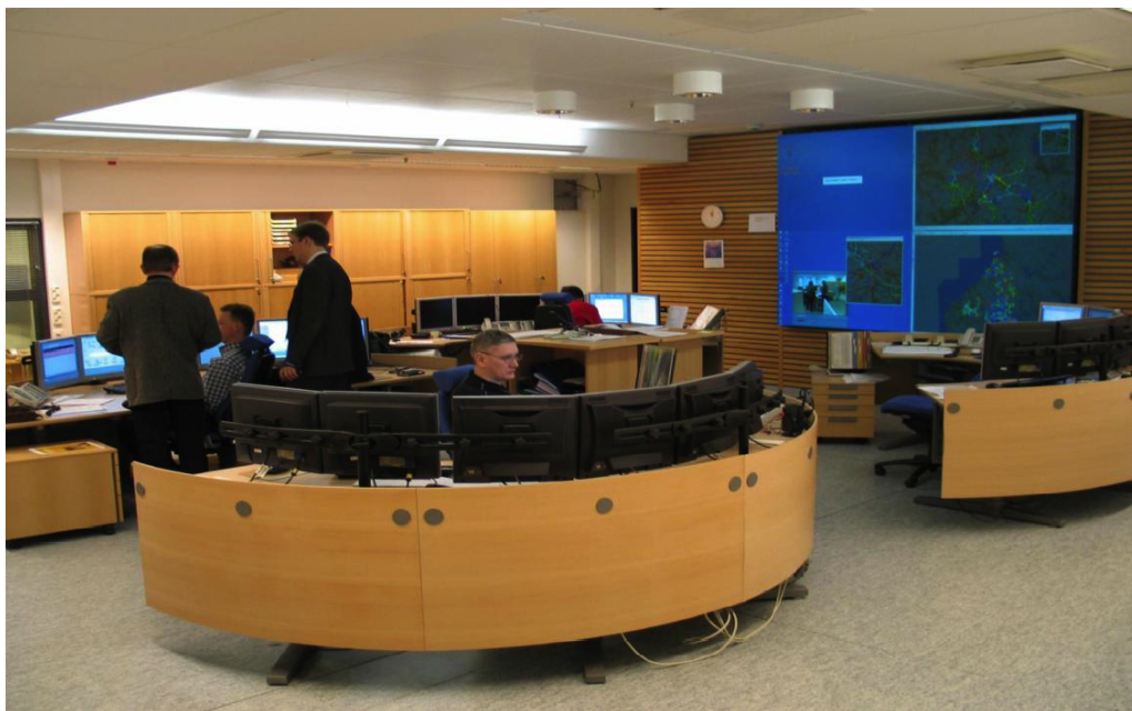
4.7 attēls. Dispečeru centrs Somijā ar uzstādīto DVS „Netcon 3000”.
