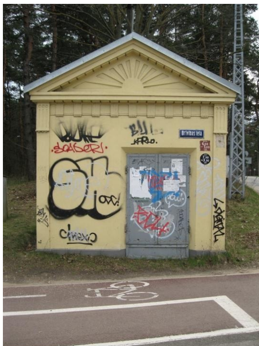
6.4. attēls. Pirmās Latvijas brīvvalsts laika transformatoru apakšstacija
