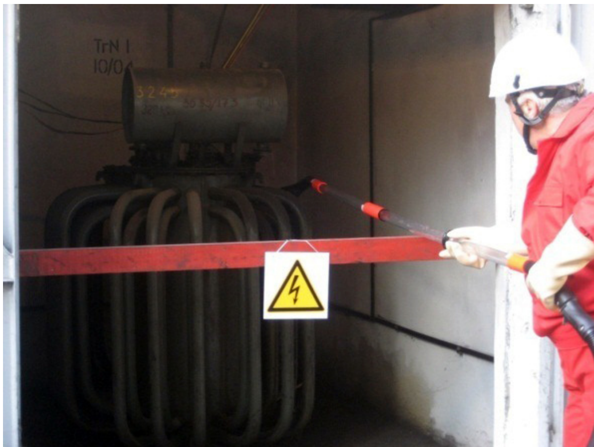
6.12. attēls. Spriegumaktīvie darbi 10/0,4 kV transformatoru apakšstacijas transformatora nodalījumā
