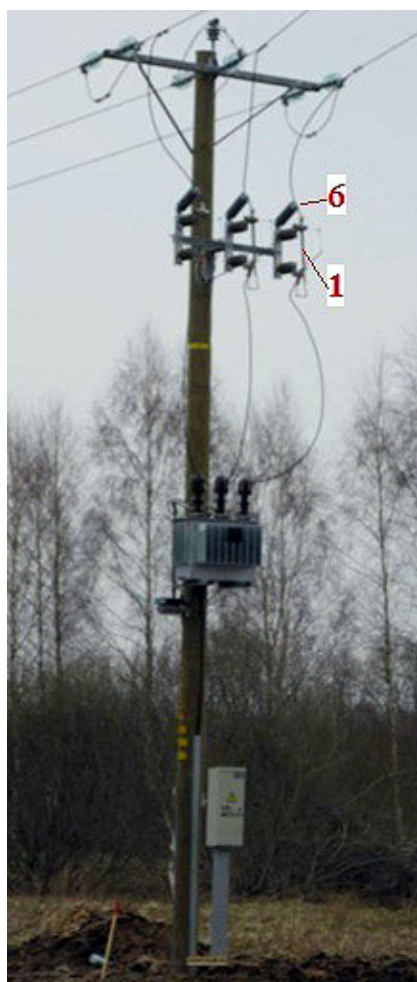
6.1. attēls. 20/0,4 kV masta apakšstacija vienstatņa balstā – jauda līdz 100 kVA un 20/0,4 kV masta apakšstacija portālbaltā - jauda līdz 400 kVA
