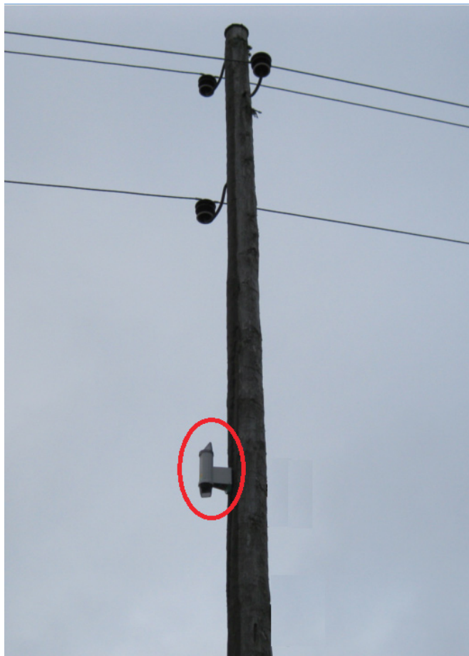
10.15. attēls. Stacionārs zemesslēguma un īsslēguma indikators 20kV GVL balstā (iezīmēts ar sarkanu līniju)
