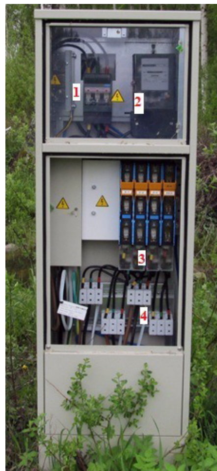
5.13. attēls. 0.4 kV sadalnes. Galvenais automātslēdzis (1), elektroenerģijas uzskaitē (2), atejošo fīderu kūstošo drošinātāju bloks (3), kopņu sistēma ar kabeļu pievienojumiem (4)
