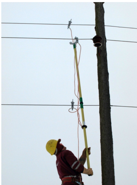
13.7. attēls. Pārnesamā zemējuma uzlikšana 20kV līnijai
