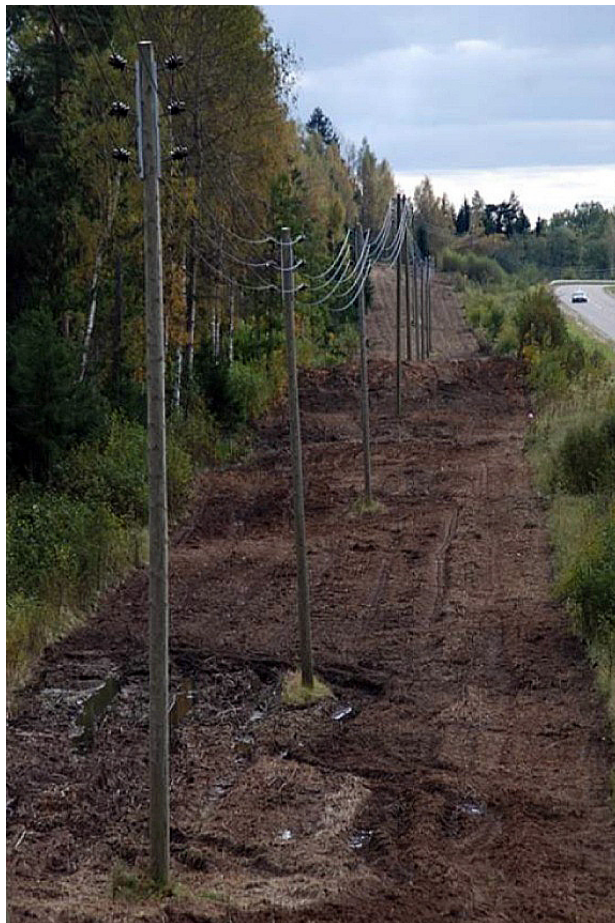
10.5. attēls. 20kV GVL ar izolētu vadu (SAX, PAS)
