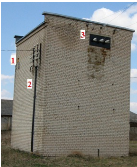
6.3. attēls. Iebūvētā 20/0,4 kV transformatoru apakšstacija (izbūvēta pirms 30 gadiem) un skats uz sausā transformatora pievienojumu 10/0,4 kV apakšstacijā. Atejošā zemsprieguma līnija ar piekarkabeli (1), ar kabeli (2), pienākošā 20 kV gaisvadu līnija (3), kabeļu pievienojums sausajam transformatoram (4)
