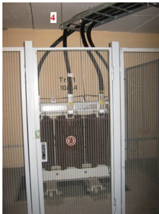
6.3. attēls. Iebūvētā 20/0,4 kV transformatoru apakšstacija (izbūvēta pirms 30 gadiem) un skats uz sausā transformatora pievienojumu 10/0,4 kV apakšstacijā. Atejošā zemsprieguma līnija ar piekarkabeli (1), ar kabeli (2), pienākošā 20 kV gaisvadu līnija (3), kabeļu pievienojums sausajam transformatoram (4)
