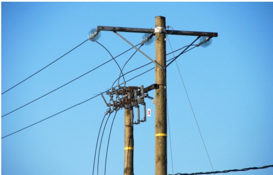
8.3. attēls. GVL pārsprieguma aizsardzība ar izlādņiem (1)
