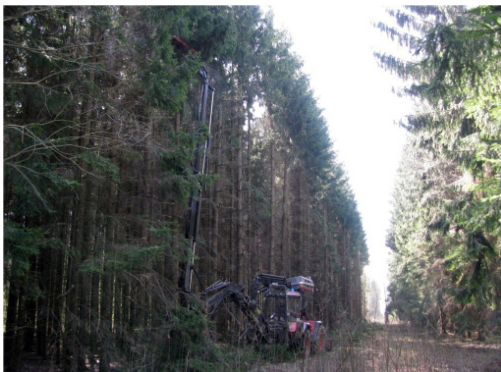
10.9. attēls. 20kV GVL trases vertikālā zaru apzāģēšana
